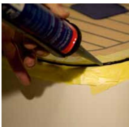
Vul de gaten met behulp van kit en de kitspuit.
