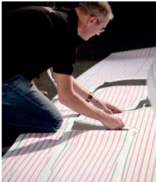
Puzzel de folieprint op een vlakke en schone ondergrond in elkaar.
