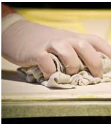
Ontvet alle delen van het scheepsdek waarop Esthec® wordt aangebracht met aceton.
