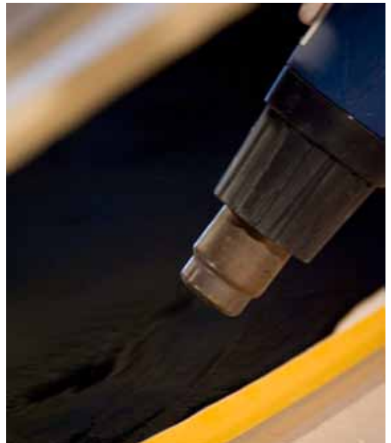
Föhn het paneel enkele minuten.
