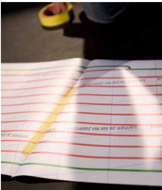
Gebruik schilderstape om de losse delen ter hoogte van de blauwe grenslijn aan elkaar te verbinden.
