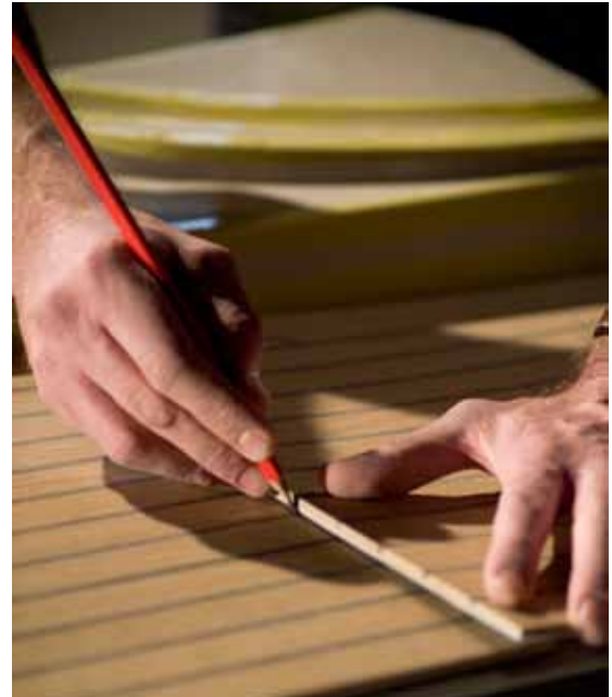
Markeer met een timmermanspotlood de lijmverbindingen op alle Esthec® panelen.
