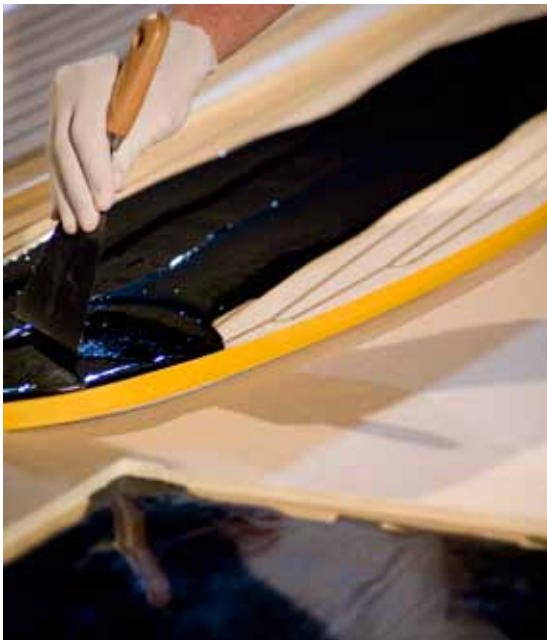
Giet de Esthec® Pattern Filler net boven het Esthec® oppervlak uit over het paneel. Ver-spreid het gelijkmatig met een plamuurmes.
