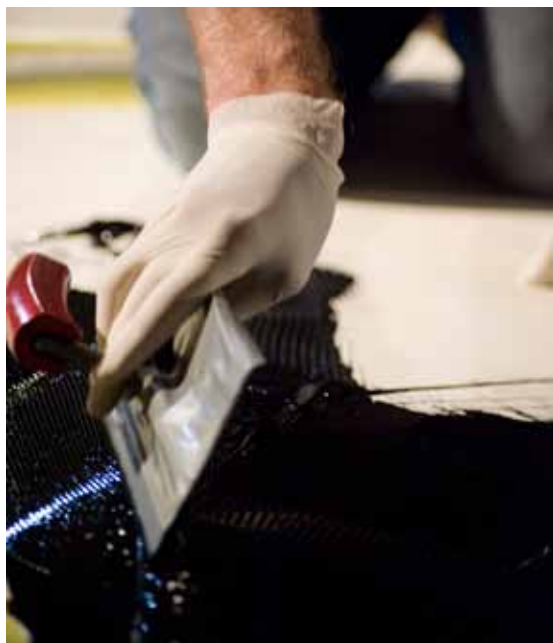
Smeer de aangebrachte kit langs de randen in een rechte lijn uit, van de rand af.
