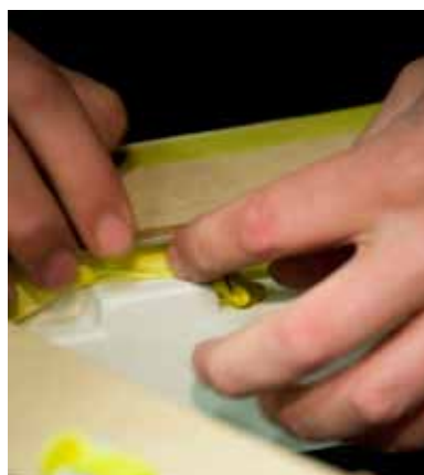
De tacky tape moet aangebracht worden rondom alle plaatsen waar Esthec® panelen worden verlijmd.
