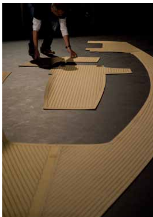
Leg de losse Esthec® panelen uit op de (gecreëerde) ondergrond zodat het dek volledig wordt gevormd.
