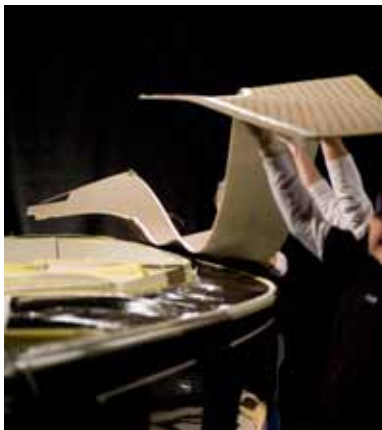
Til het juiste Esthec ® paneel van de grond en houd deze eerst boven het schip, om het in de lucht naar de juiste plaats te bewegen.
