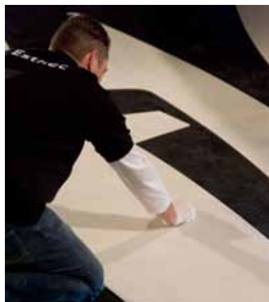
Ontvet tevens de GRP backing van de Esthec® panelen.
