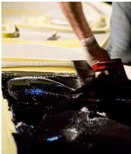
Smeer de aangebrachte kit op de overige delen van het scheepsdek gelijkmatig met vloeiende draaibewegingen uit.
