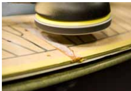
Overtollige lijm bovenop de Esthec® panelen kan weg worden geschuurd.
